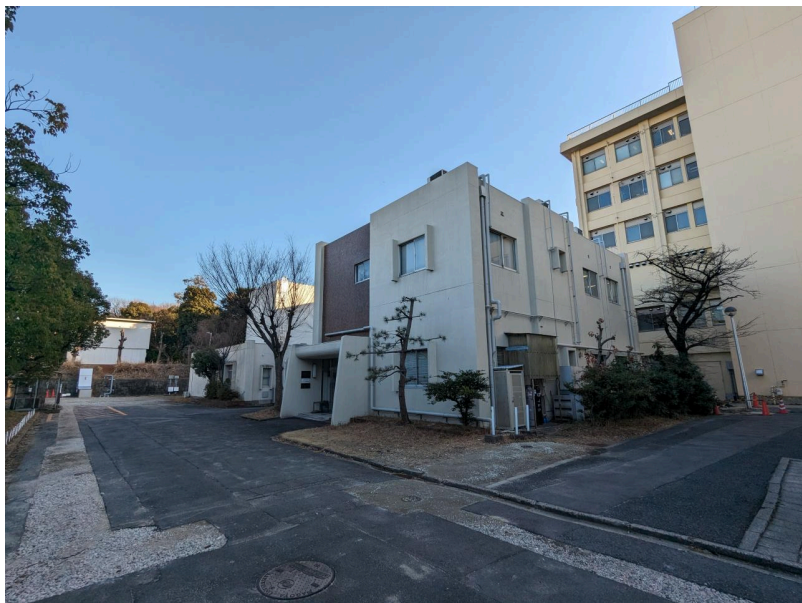
超高压高温発生装置室。おおよそ南東を向いて撮影。2024年2月7日撮影。
