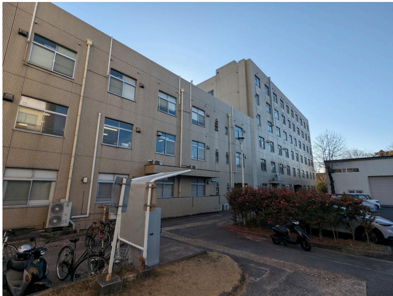
工学部9号館。館内に土木図書室がある。おおよそ南西を向いて撮影。2024年2月7日撮影。
