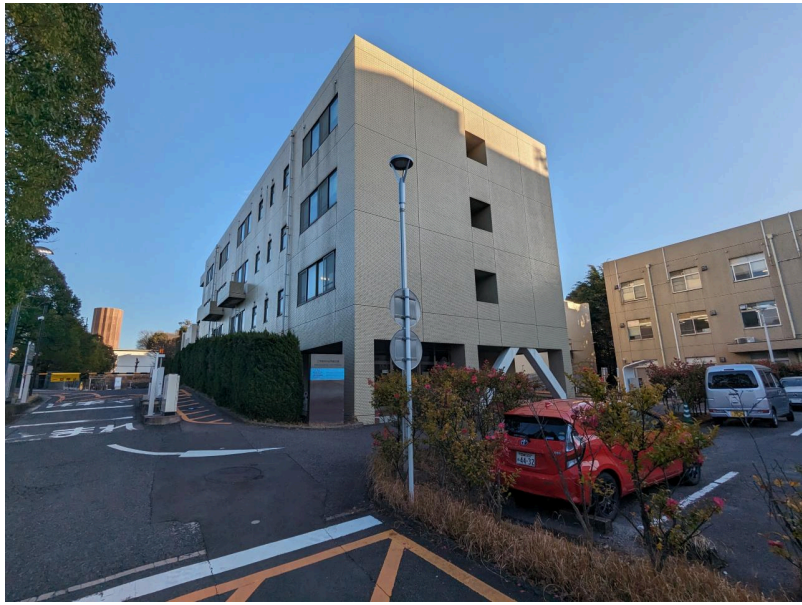
工学部8号館北棟。南東を向いて撮影。2024年2月7日撮影。
