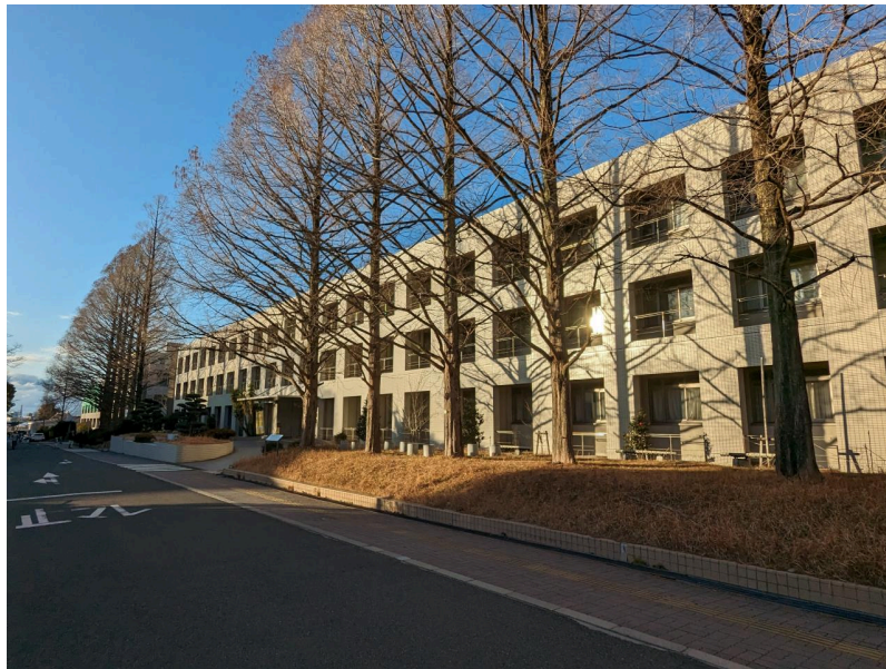
教育学部本館。この建物の前には車両出入口がある。アメニティハウスを背にして北西を向いて撮影したもの。2024年2月7日撮影。
