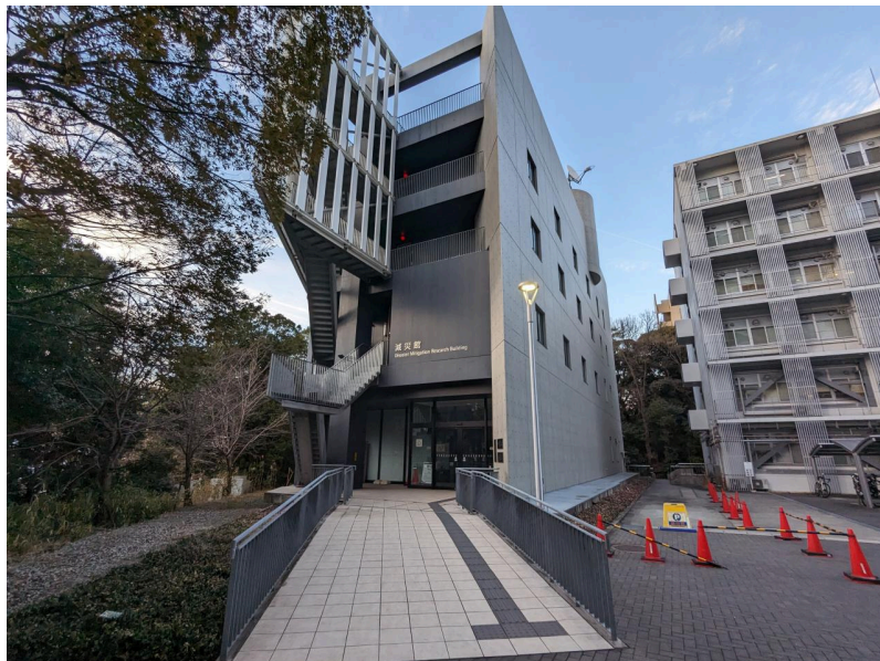
減災館。この建物は地面から少しだけ浮いており、地震の振動を吸収するバネとダンパーの上に建築されている特殊な建物である。バネとダンパーは建物北側のガラスの向こう側に見え、工学部の一部の学科では実際にこのバネやダンパーが動く様子を見る授業もある。写真はNIC館を背にして北を向いて撮影したもの。2024年2月2日撮影。
